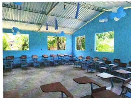
Foto 4: Area para aula 2 tipo portico
